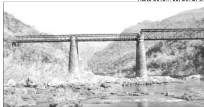
Estrutura de aço com 108m de comprimento veio da Alemanha
